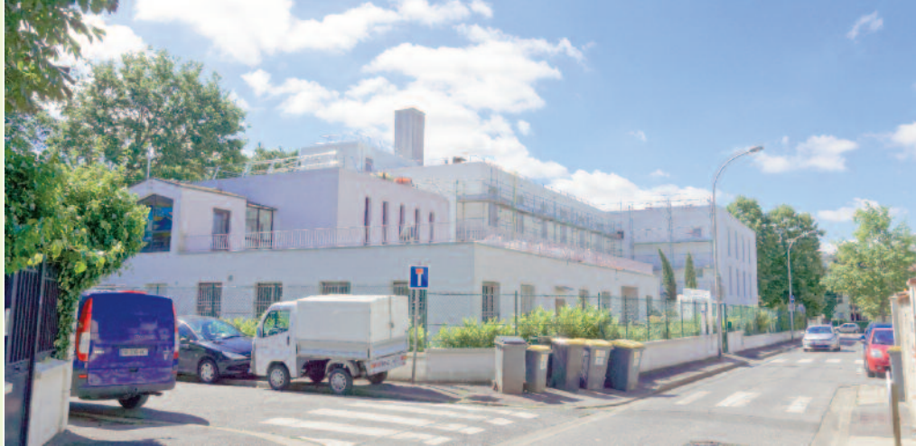
Façade de la maison de retraite de Bry-sur-Marne
