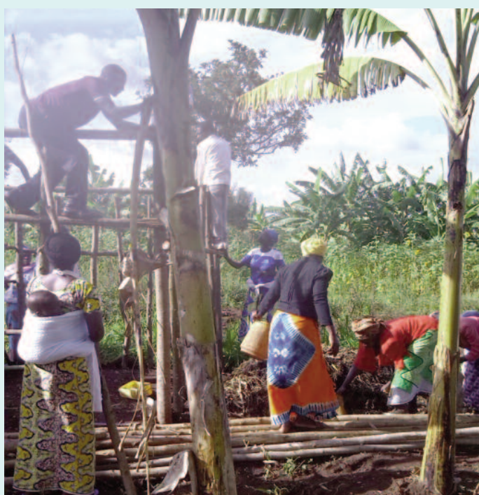
La construction de la porcherie
